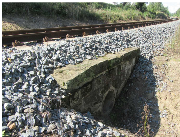
obr.: stávající propustek - pohled z boku a z kolejiště
